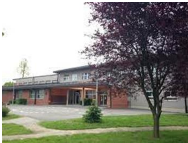
Slika 8. Zgrada osnovne škole Ivana Grande Soblinec Sesvete.
