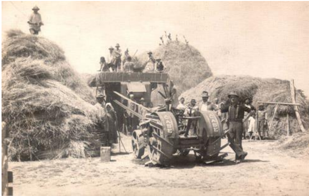
Slika 1. Stacionirana žitna vršalica
