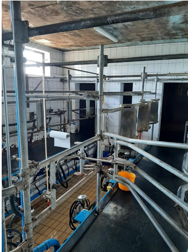
Slika 12. Izmuzište tipa Riblja kost Izvor: Vlastita fotografija
