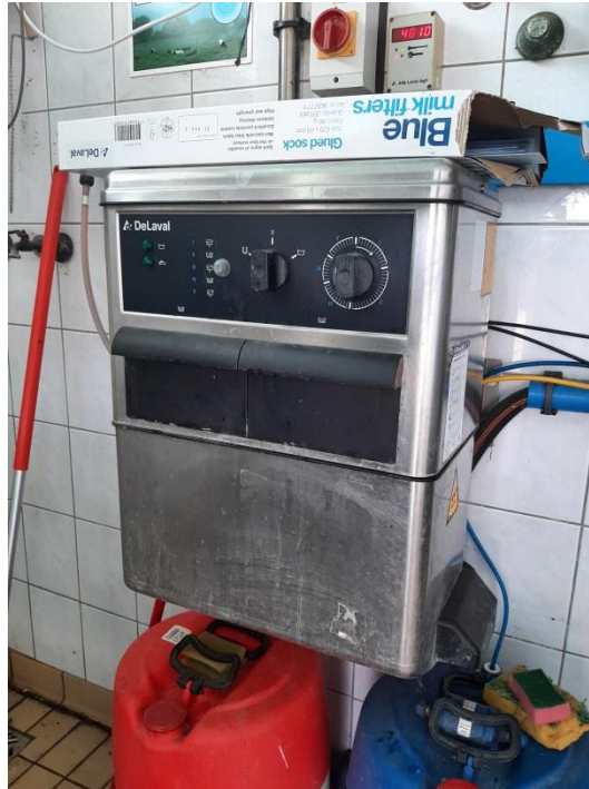
Slika 15. Uređaj za pranje muznih aparata i cijelog sustava Izvor: Vlastita fotografija
