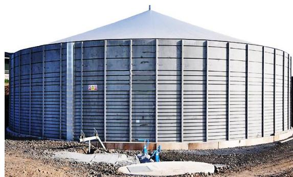
Slika 3. Nadzemni spremnik od betonskih elemenata
