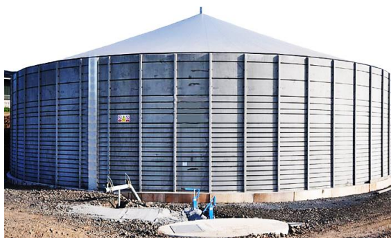
Slika 3. Nadzemni spremnik od betonskih elemenata
