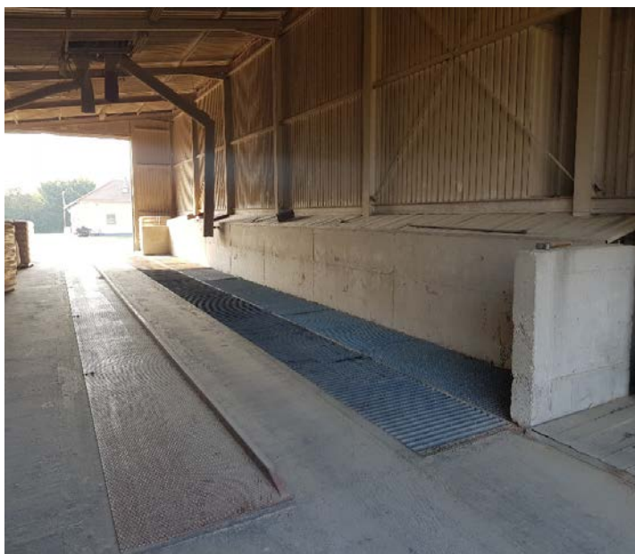
Slika 13. Usipni koš s nagibnom rampom za istovar
