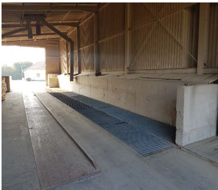
Slika 13. Usipni koš s nagibnom rampom za istovar
