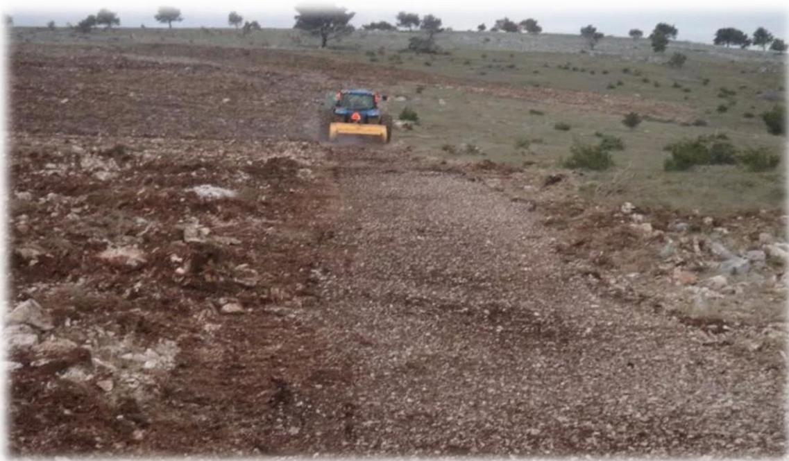
**Slika 4: Prikaz rada uređaja za usitnjavanje kamena**
