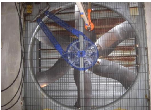
Slika 4. Tunelski ventilator
