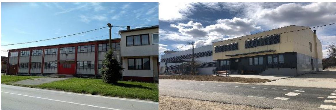
Slika 10. Obnova fasade i krova zgrade na Vavtrogasnom domu u Carevdaru
