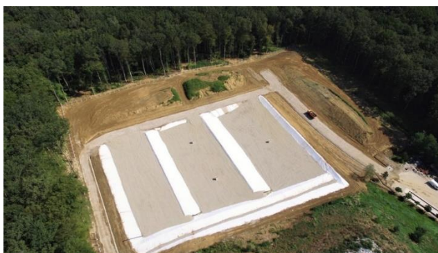
Slika 14. Prošireno odlagalište otpada “Ivančino brdo”
