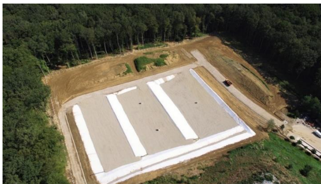
Slika 14. Prošireno odlagalište otpada “Ivančino brdo”
