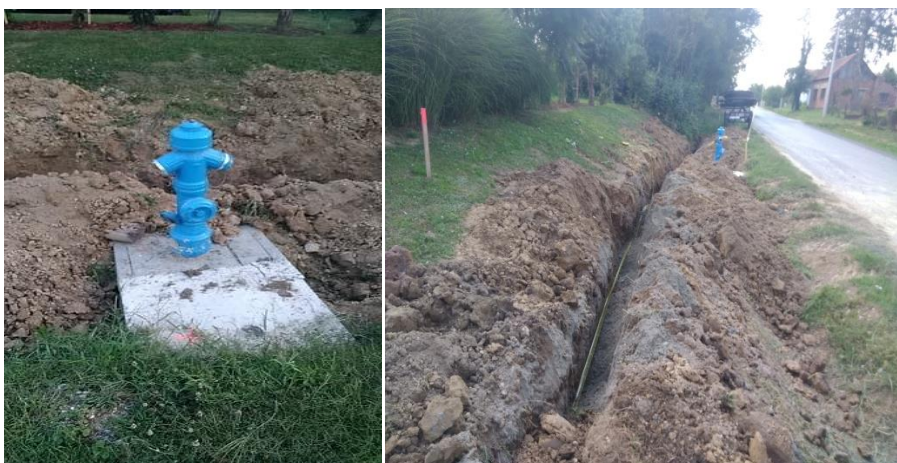
Slika 6. Gradnja vodovoda u Ulici Republici
