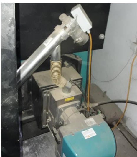
Slika 27. Pužnica koja vodi pelete u peć
