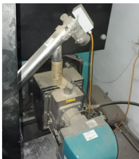
Slika 27. Pužnica koja vodi pelete u peć
