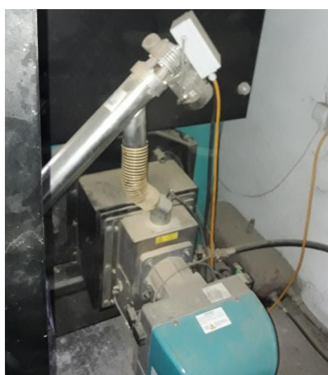
Slika 27. Pužnica koja vodi pelete u peć
