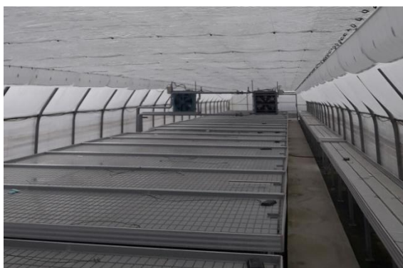
Slika 23. Plastenik opremljen energetskom zavjesom i potopnim stolovima
