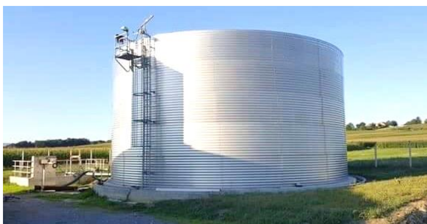
Slika 2. Nadzemni spremnik za gnojovku na OPG Đuranec
