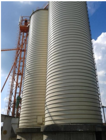
Slika 10. Silosi kapaciteta po 500 t
