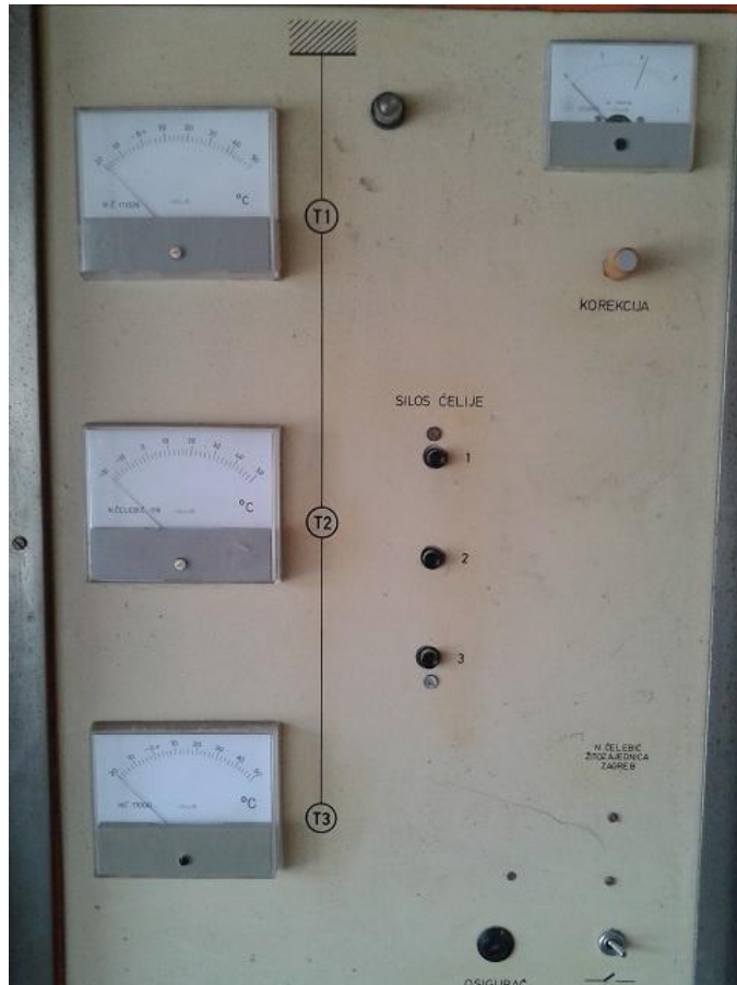
Slika 13. Pozicija 8 - kontrola temperature merkantilne pšenice
