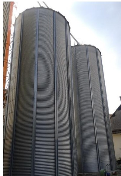
Slika 11. Silosi kapaciteta po 250 t
