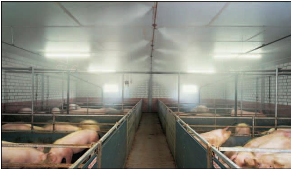
Slika 18. Prikaz rada CombiCool sustava za hlađenje
