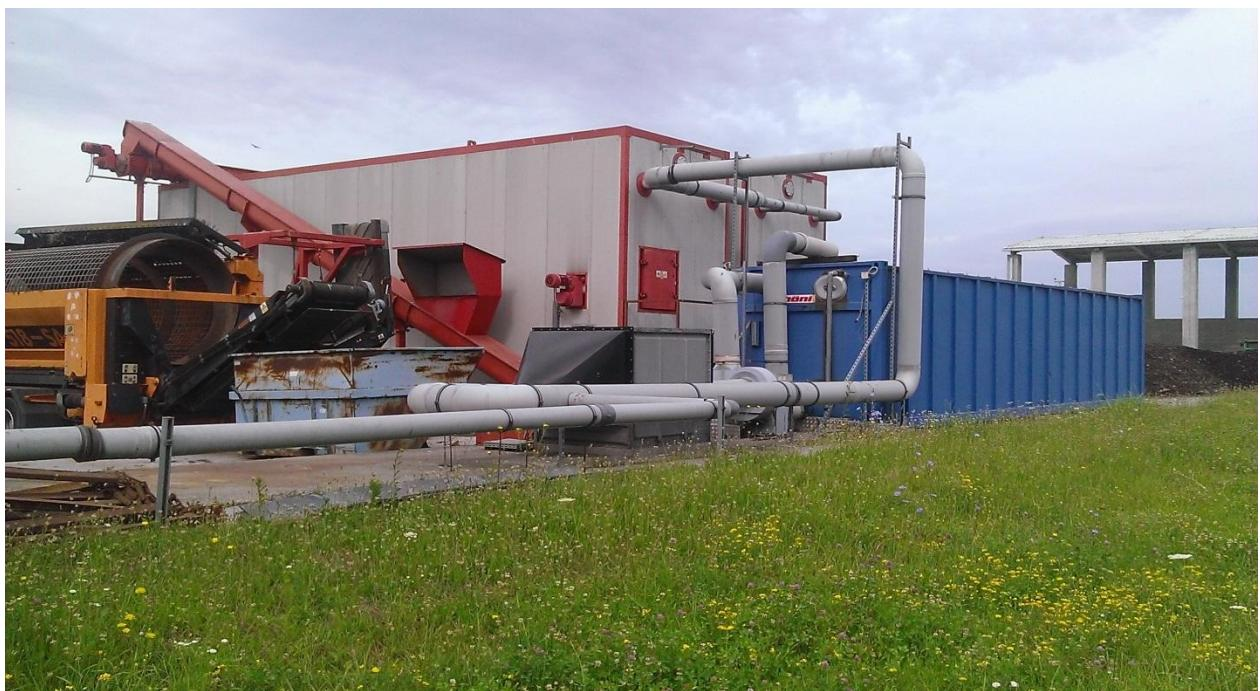
Slika 16. Zatvoren tip kompostane (2 komore, pužni transporter i sustav za pročišćavanje zraka)
