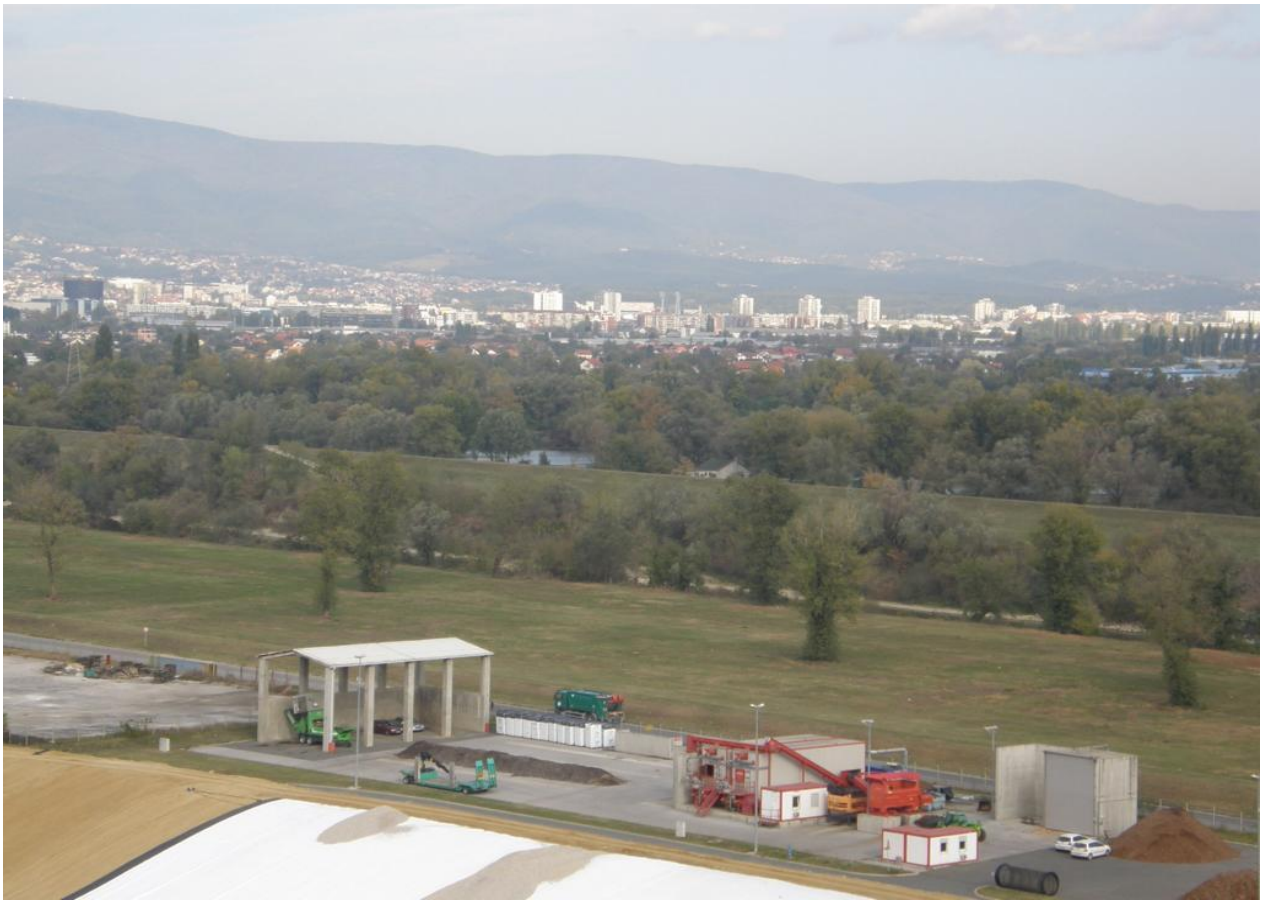
Slika 1. Postrojenje kompostane Jakuševac Izvor: Arhiva Zagrebački Holding podružnica Zrinjevac
