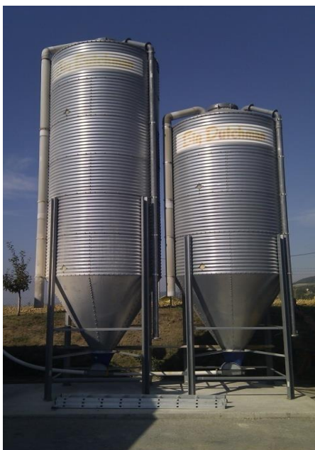
Slika2. Silosi za skladištenje hrane
