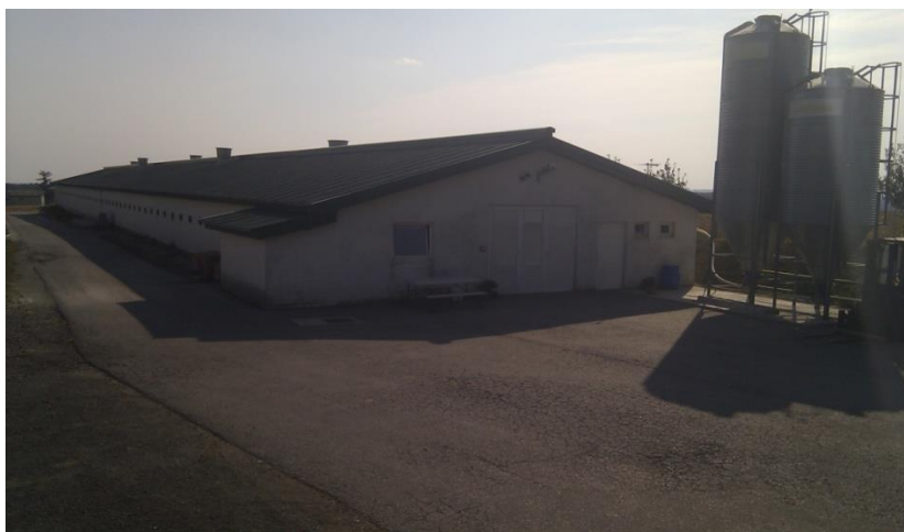
Slika1. Peradnjak s popratnim objektima
