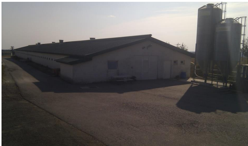
Slika1. Peradnjak s popratnim objektima
