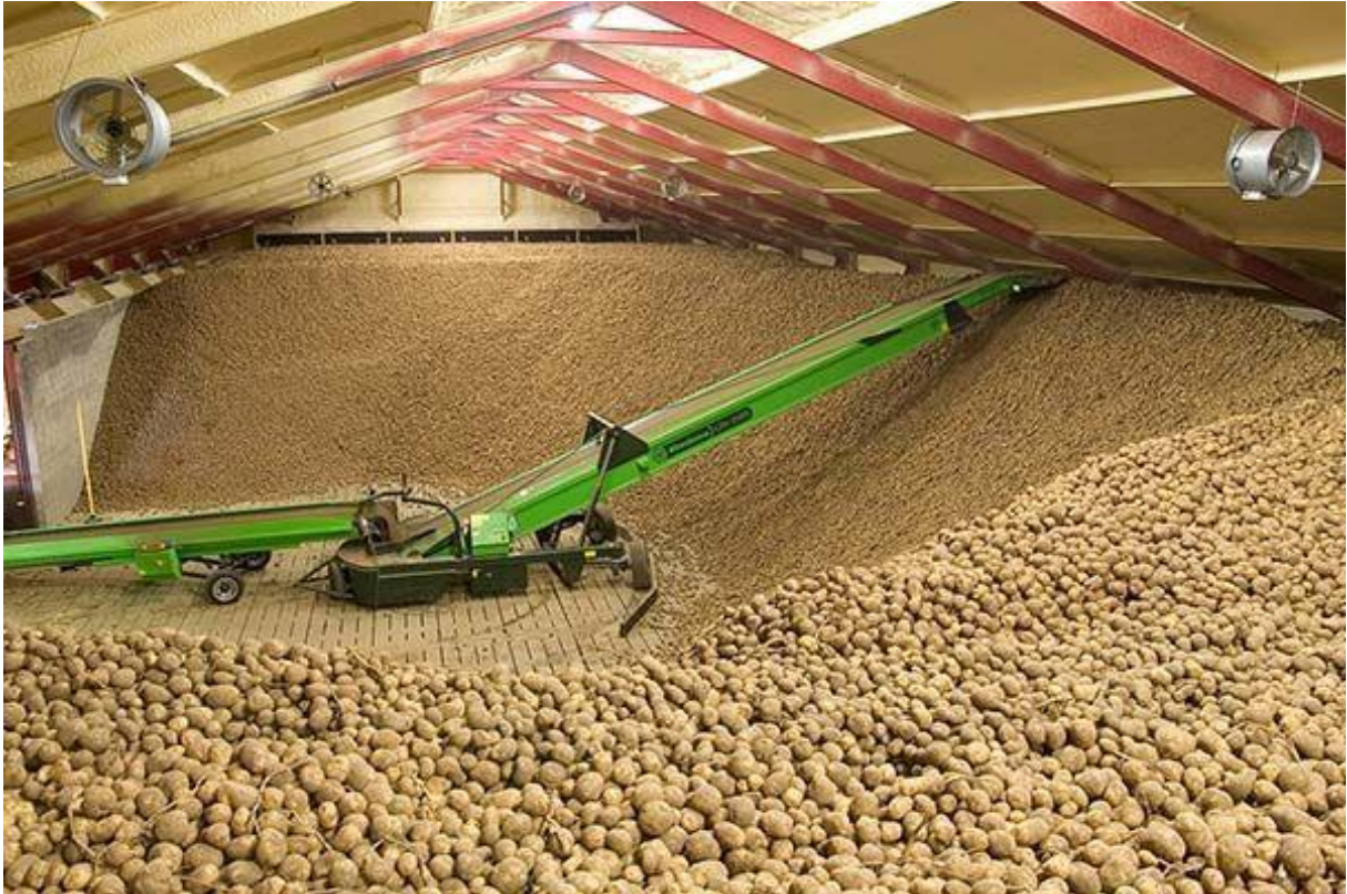
Slika 9. Podno rinfuzno skladište krumpira
