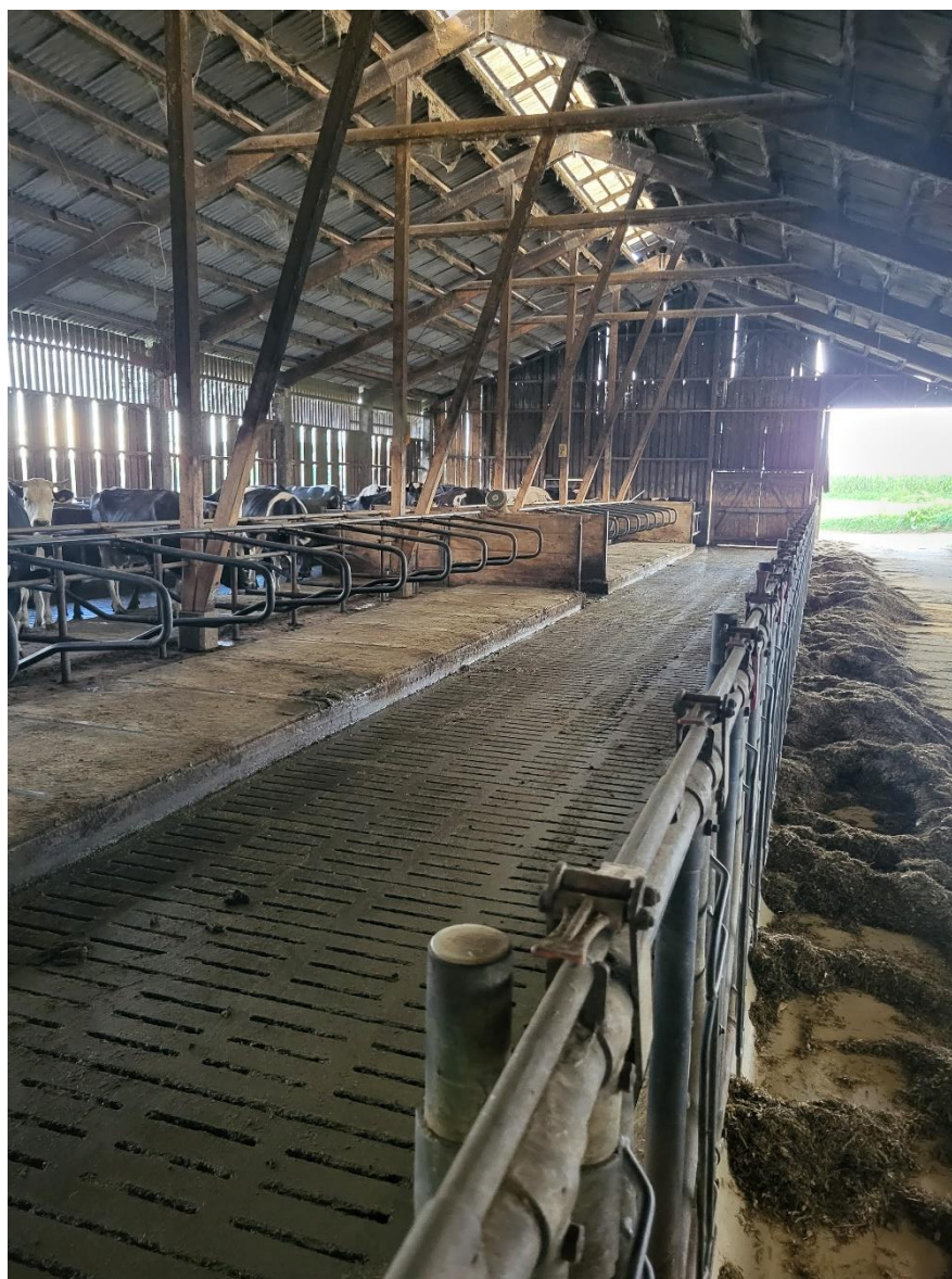
Slika 6. Staja s betonskim gredicama
