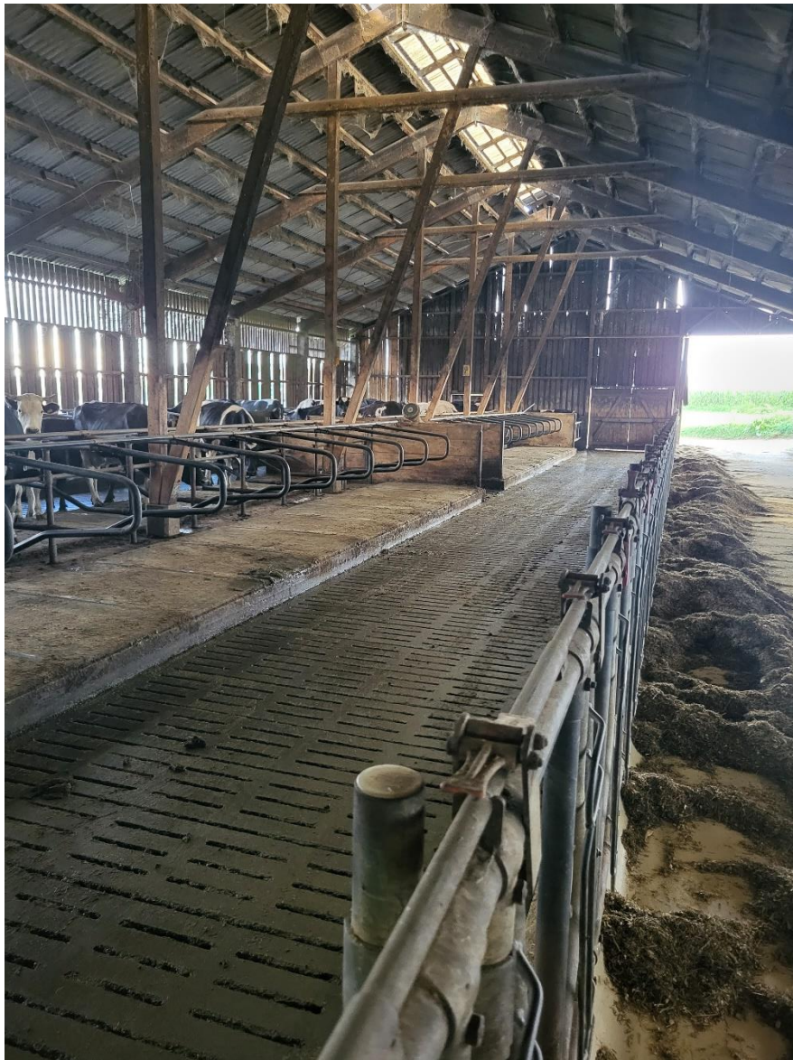
Slika 6. Staja s betonskim gredicama
