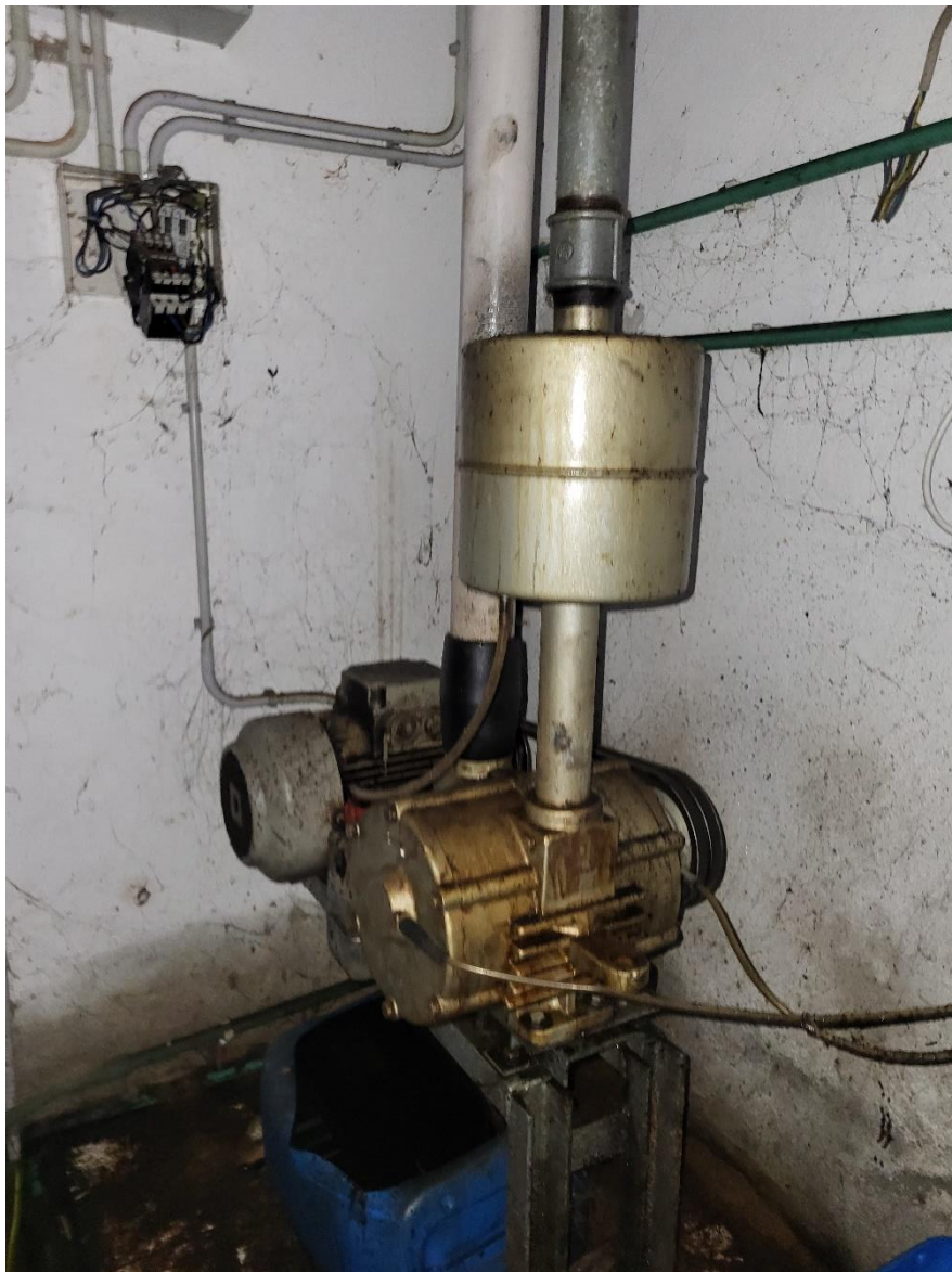
Slika 9. Vakuumska pumpa
