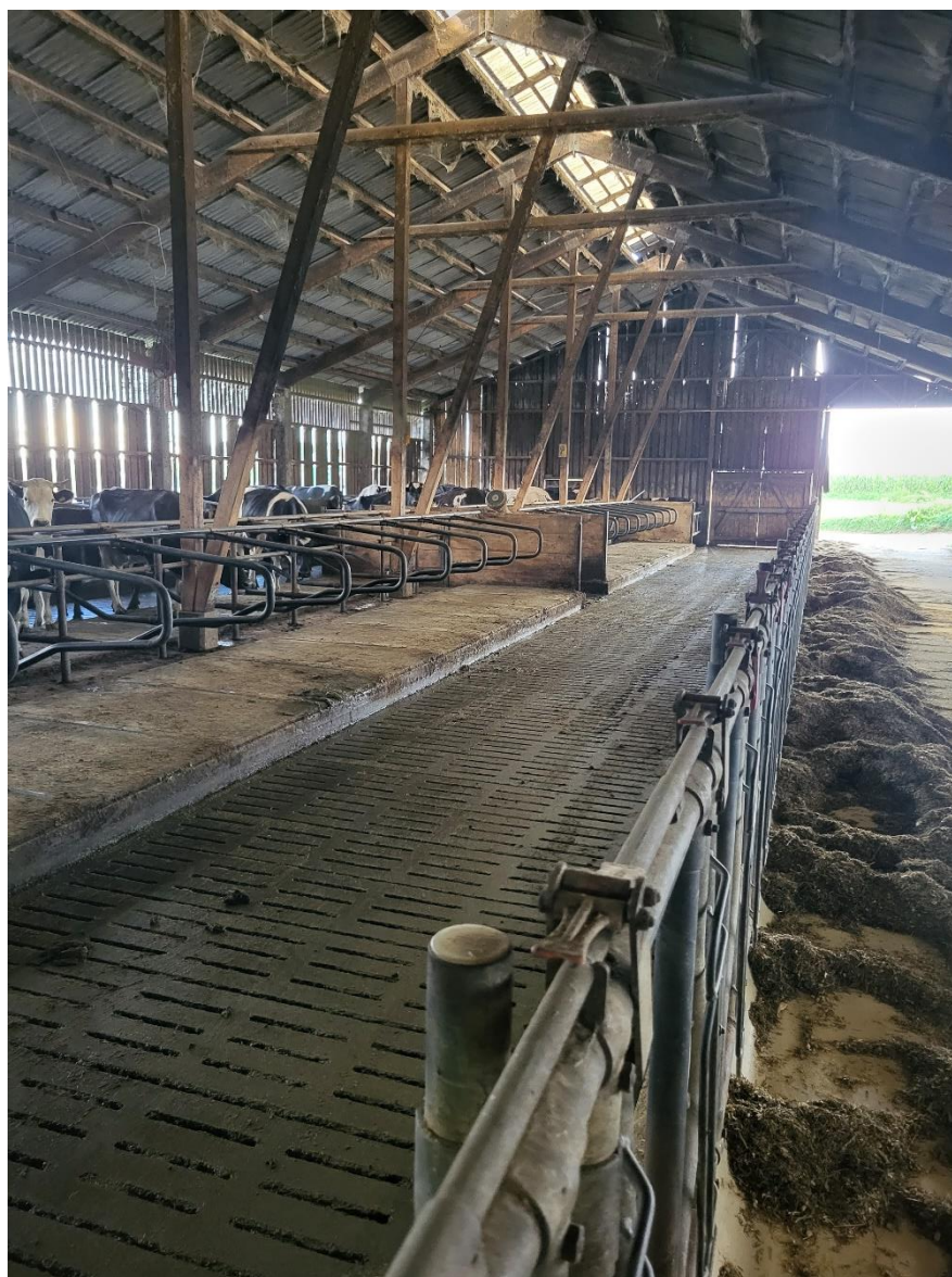
Slika 6. Staja s betonskim gredicama
