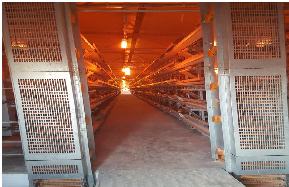
Slika 2. Hodnik i baterije u peradnjaku Izvor: Vlastita fotografija
