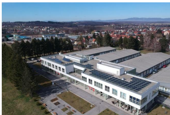
Slika 15. Fotonaponske elektrane na krovu upravne zgrade Razvojnog centra i tehnološkog parka Križevci
