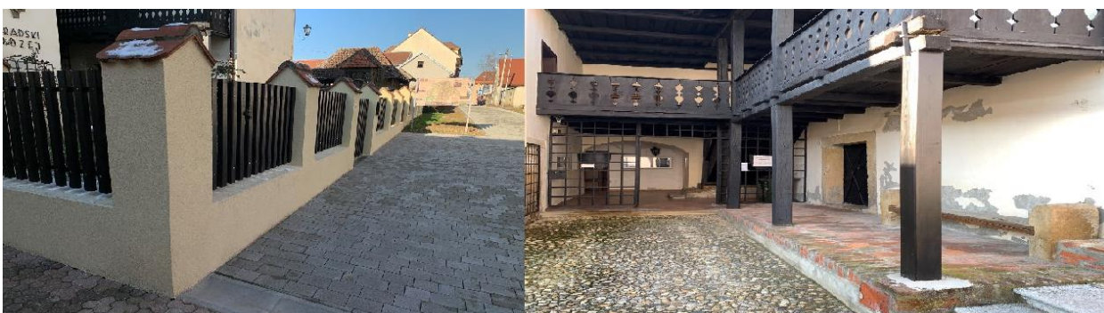
Slika 4. Obnovljen prednji dio ograde i zamijenjen novi drveni stup
