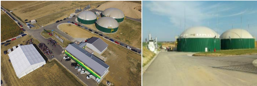
Slika 13. i 14. Pogled na bioplinско postrojenje
