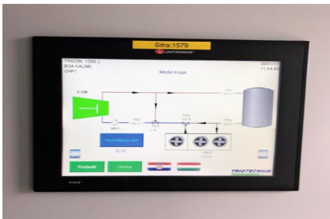
Slika 24. Kontrola sustava za bioplin
