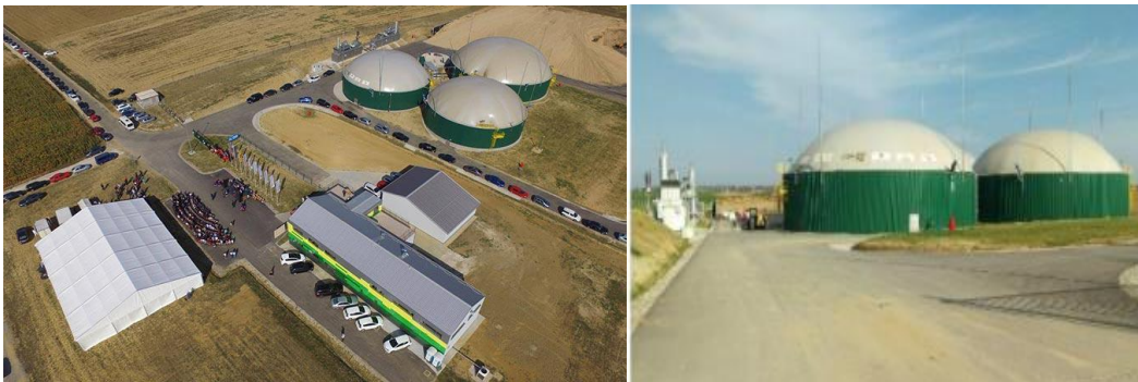
Slika 13. i 14. Pogled na bioplinско postrojenje
