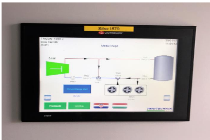
Slika 24. Kontrola sustava za bioplin
