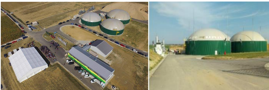
Slika 13. i 14. Pogled na bioplinско postrojenje
