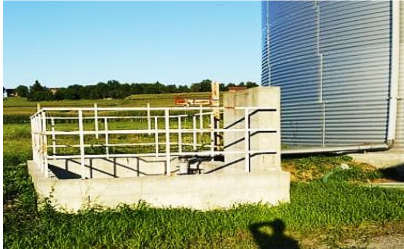
Slika 6. Pred laguna i laguna za gnojovku na OPG-u Đuranec (Izvor: Vlastita fotografija)
