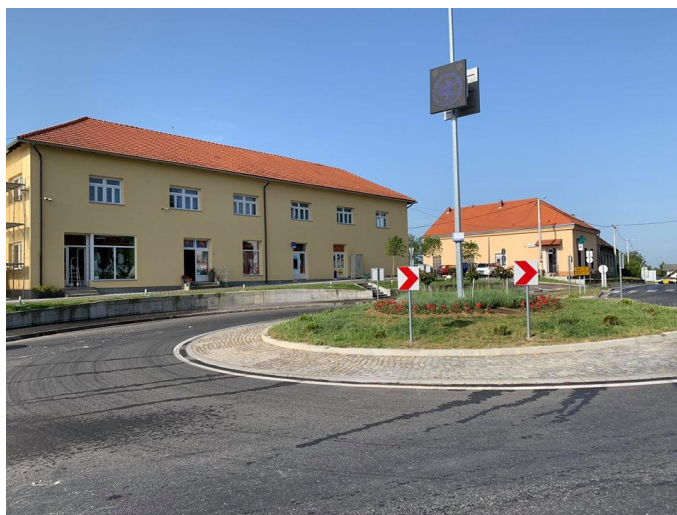
Slika 8. Izgrađeni kružni tok
