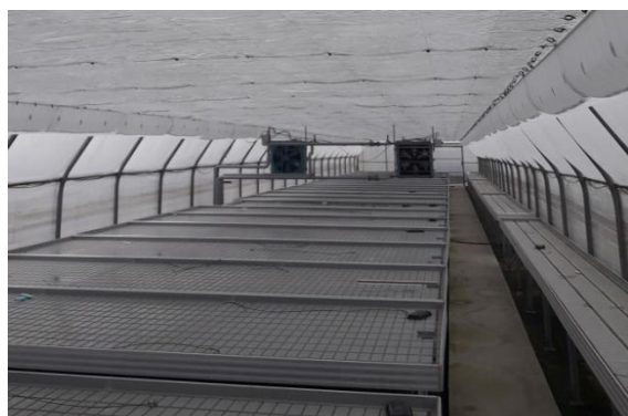
Slika 23. Plastenik opremljen energetskom zavjesom i potopnim stolovima
