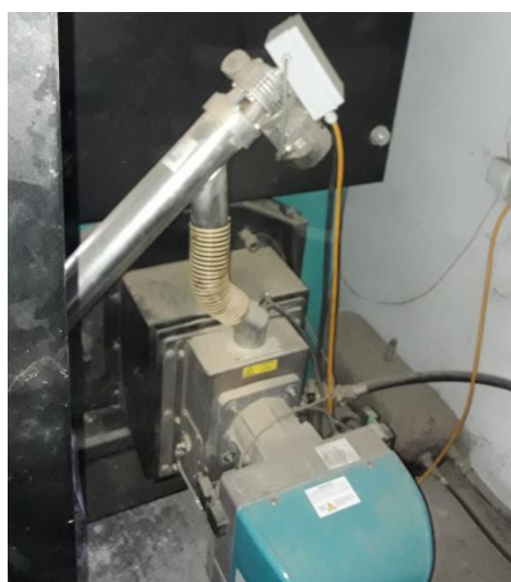
Slika 27. Pužnica koja vodi pelete u peć
