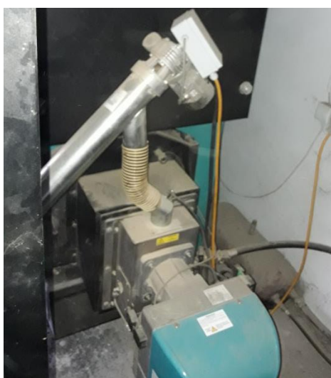
Slika 27. Pužnica koja vodi pelete u peć
