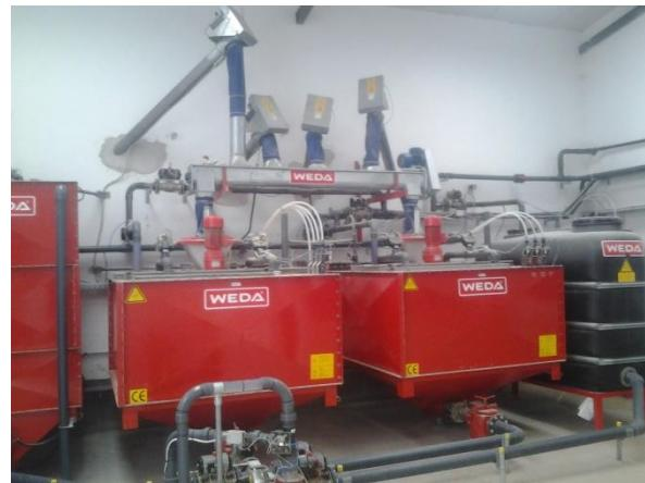
Slika 13. Rezervoar s mješačem
