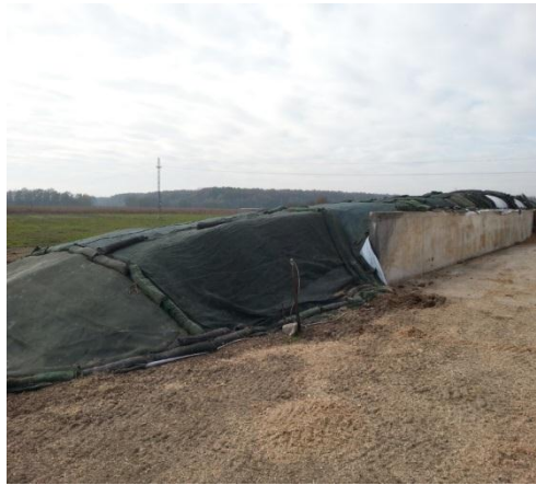
Slika 6. Silos sa betonskim okvirom i silo hrpa
