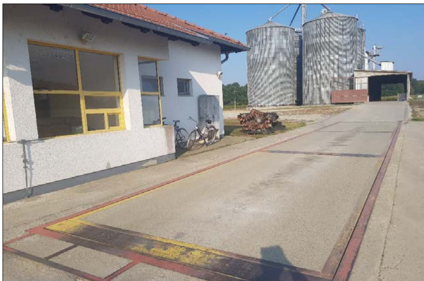
Slika 5. Vanjski dio mostne vage (Fotografija: F. Rutić)
