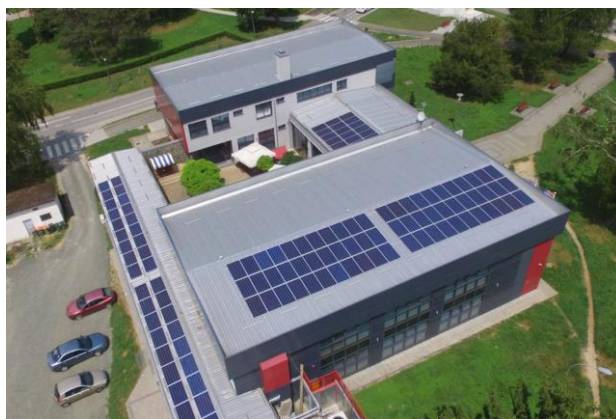
Slika 16. Solarna elektrana na krovu Gradske knjižnice
