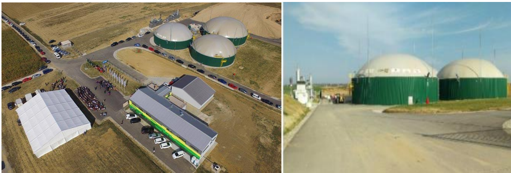
Slika 13. i 14. Pogled na bioplinско postrojenje
