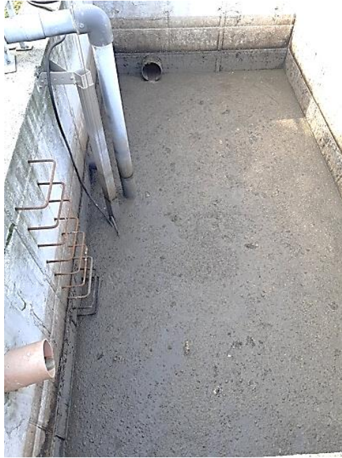
Slika 10. Pred laguna sa potopnom crpkom na OPG-u Đuranec (Izvor: Vlastita fotografija)
