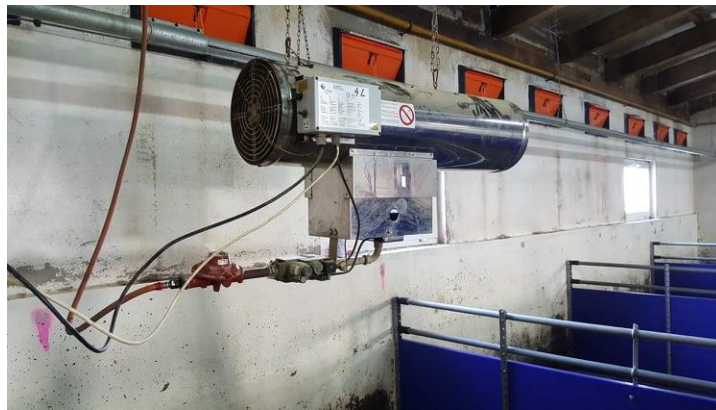
Slika 4. Jet-Master „top“ za zagrijavanje objekta (Izvor: Vlastita fotografija)
