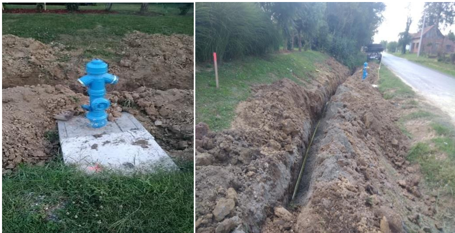
Slika 6. Gradnja vodovoda u Ulici Republici
