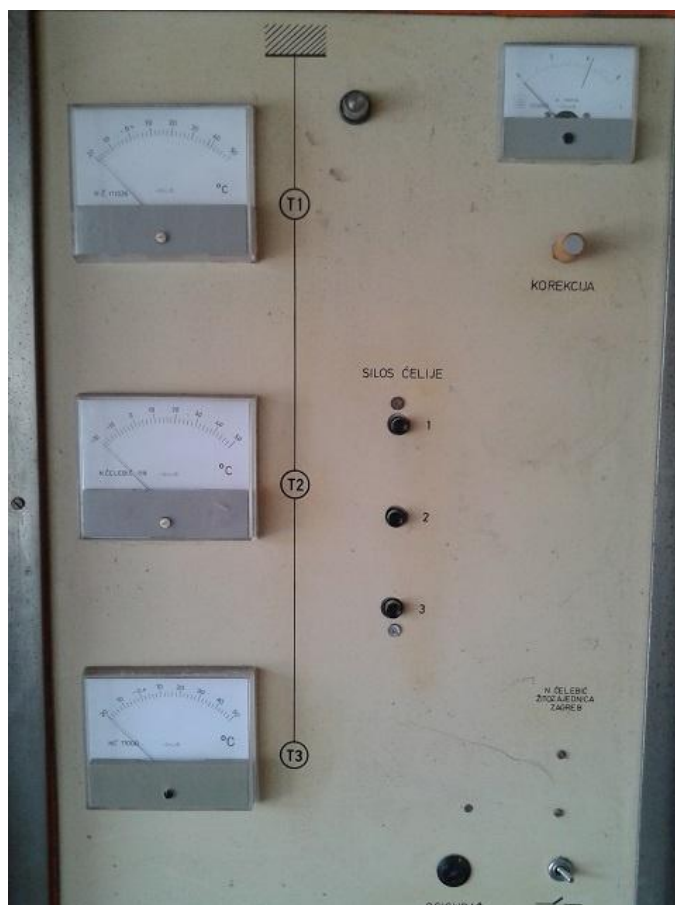
Slika 13. Pozicija 8 - kontrola temperature merkantilne pšenice
