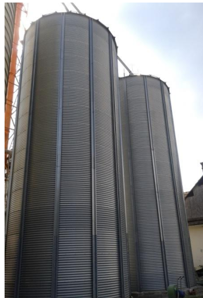
Slika 11. Silosi kapaciteta po 250 t
