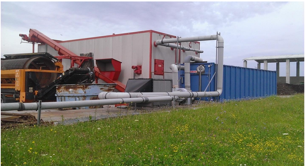
Slika 16. Zatvoreni tip kompostane (2 komore, pužni transporter i sustav za pročišćavanje zraka)
