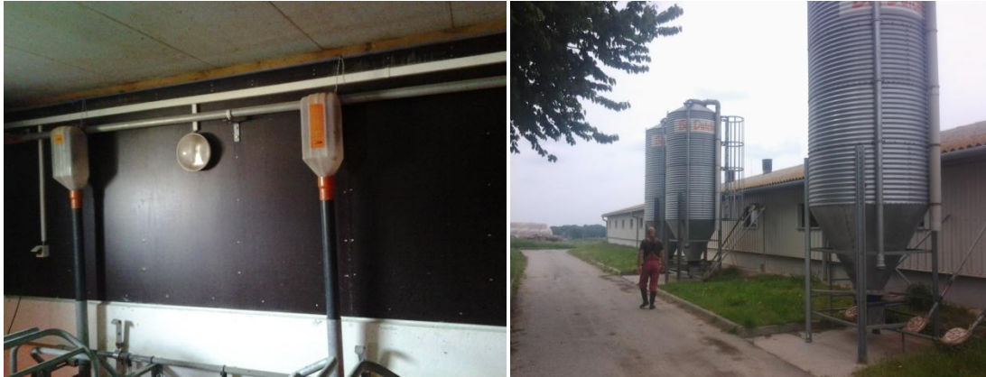
Slika 12. Hranidba s cijevnim konvejerom i volumnim dozatorima
