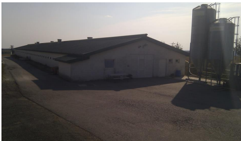
Slika1. Peradnjak s popratnim objektima
